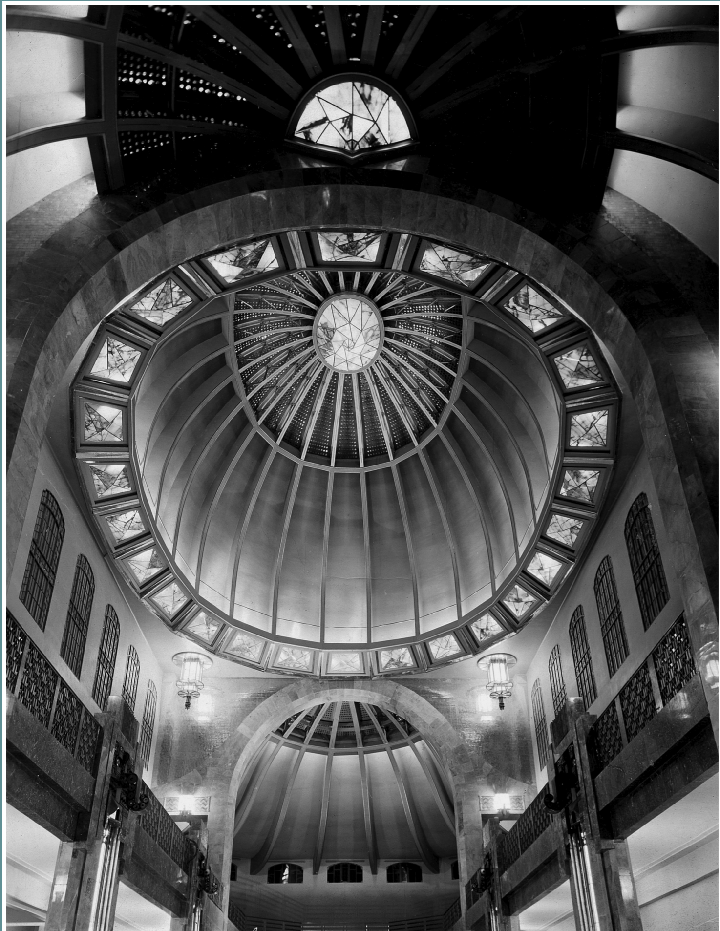
Interior de las cúpulas recién concluidas del Palacio de Bellas Artes. Ciudad de México, 1934. Archivo DACPAI. INBA.
