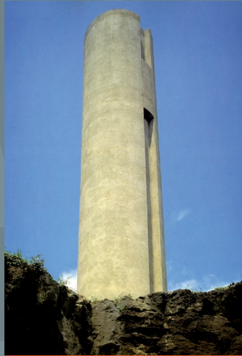
Torre de agua para la Unidad Habitacional la Cantera
