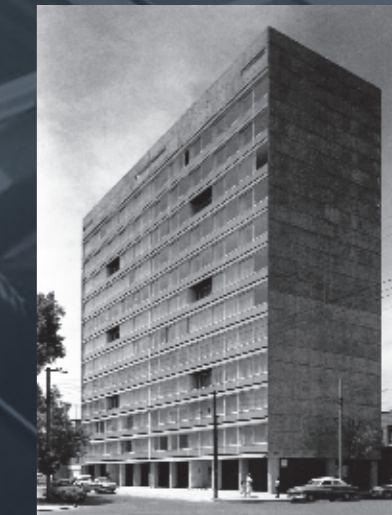
Fachada, esquina noreste
