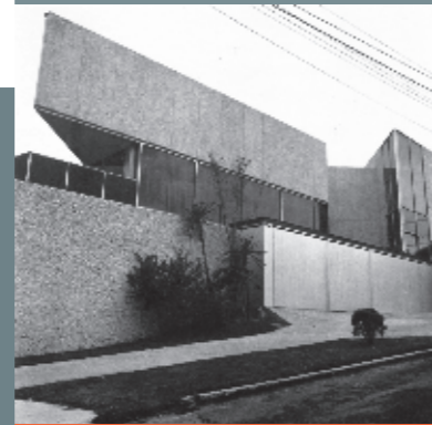
Detalle de la fachada
